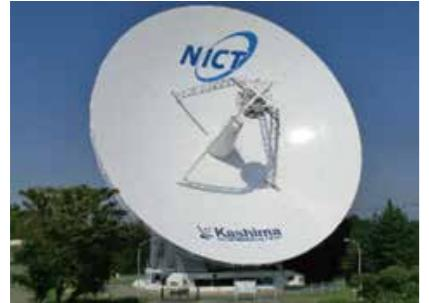
34mアンテナは1988年に西太平洋電波干渉計プロジェクトの本土局として建設され、鹿島宇宙技術センター歴代のアンテナの中で最大のものでした。高い鏡面精度、副反射鏡制御機構、トロリー式受信機交換システムなどを備えることにより、1.35GHzから43GHzまでにわたる広い周波数帯域をカバーし、測地VLBI(超長基線電波干渉法)、電波天文、電波科学などさまざまな分野での観測・研究を行いました。
